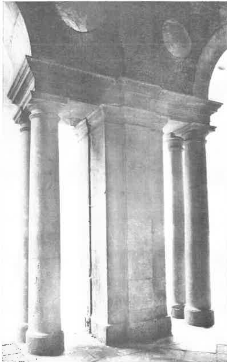
2 - A. PALLADIO: Colonne binate e pilastro intermedio delle serliane nelle Logge inferiori della Basilica, Vicenza.
