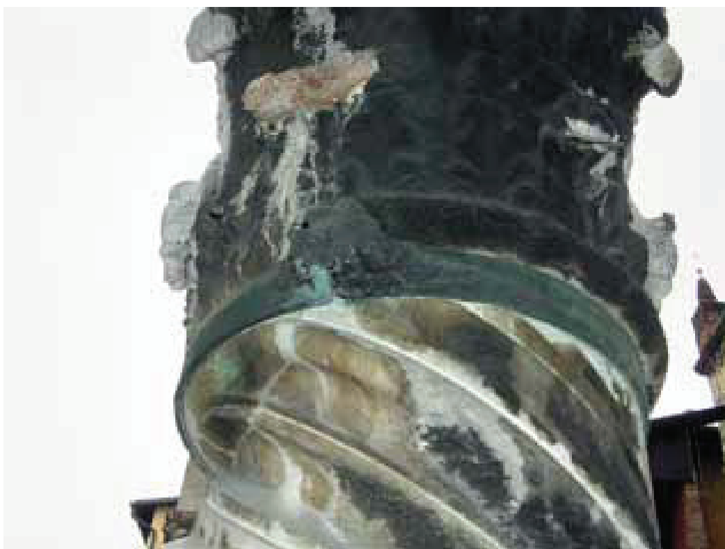
Figure 1 e 2. Restauro dell'arca di Cansignorio della Scala. Immagini prima dell'intervento.
