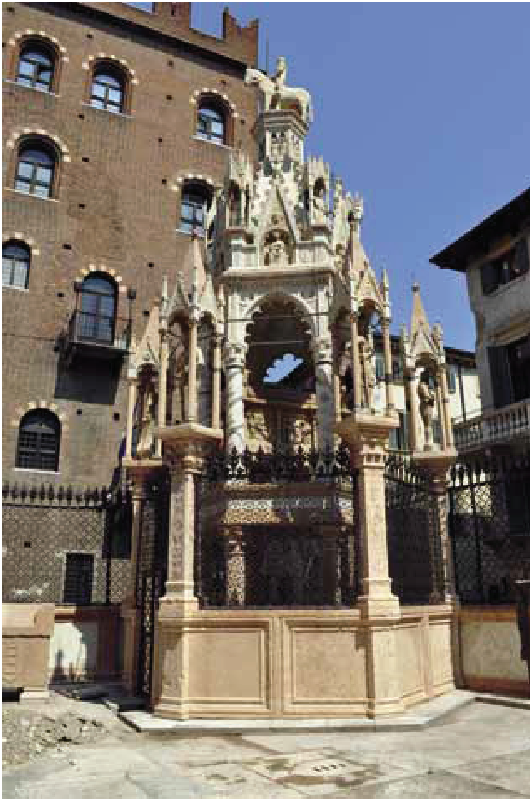
Figura 8. Restauro dell'arca di Cansignorio della Scala. Immagine dopo l'intervento.
