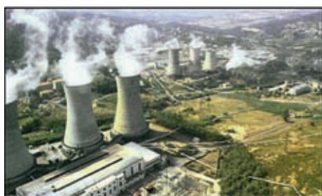
Figura 9. Larderello (Pisa). Torri di raffreddamento del vapore.
